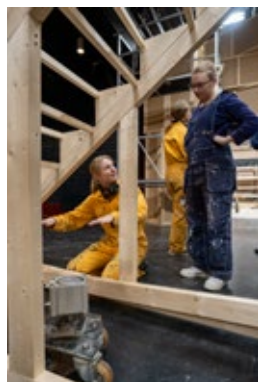
Ingen revy utan primadonnetrappa. Höjden på årets trappa regleras genom pneumatik. Rebecca Niska och Sonja Winge diskuterar tryckluftsförlustproblem.
