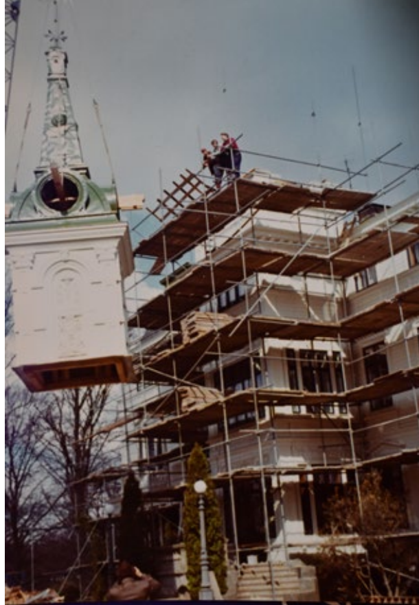
Symbolen för Wendelsberg – klocktornet – lyftes ner den 3 mars för en grundlig restaurering på marken. På självaste valborgsmässoafton var arbetena klara och tornet höjdes med hjälp av den (på den tiden) väldiga kranen mot skyarna igen, vilket sedan firades med, vårtal, eld, fackeltåg, vårmåltid och dans.
