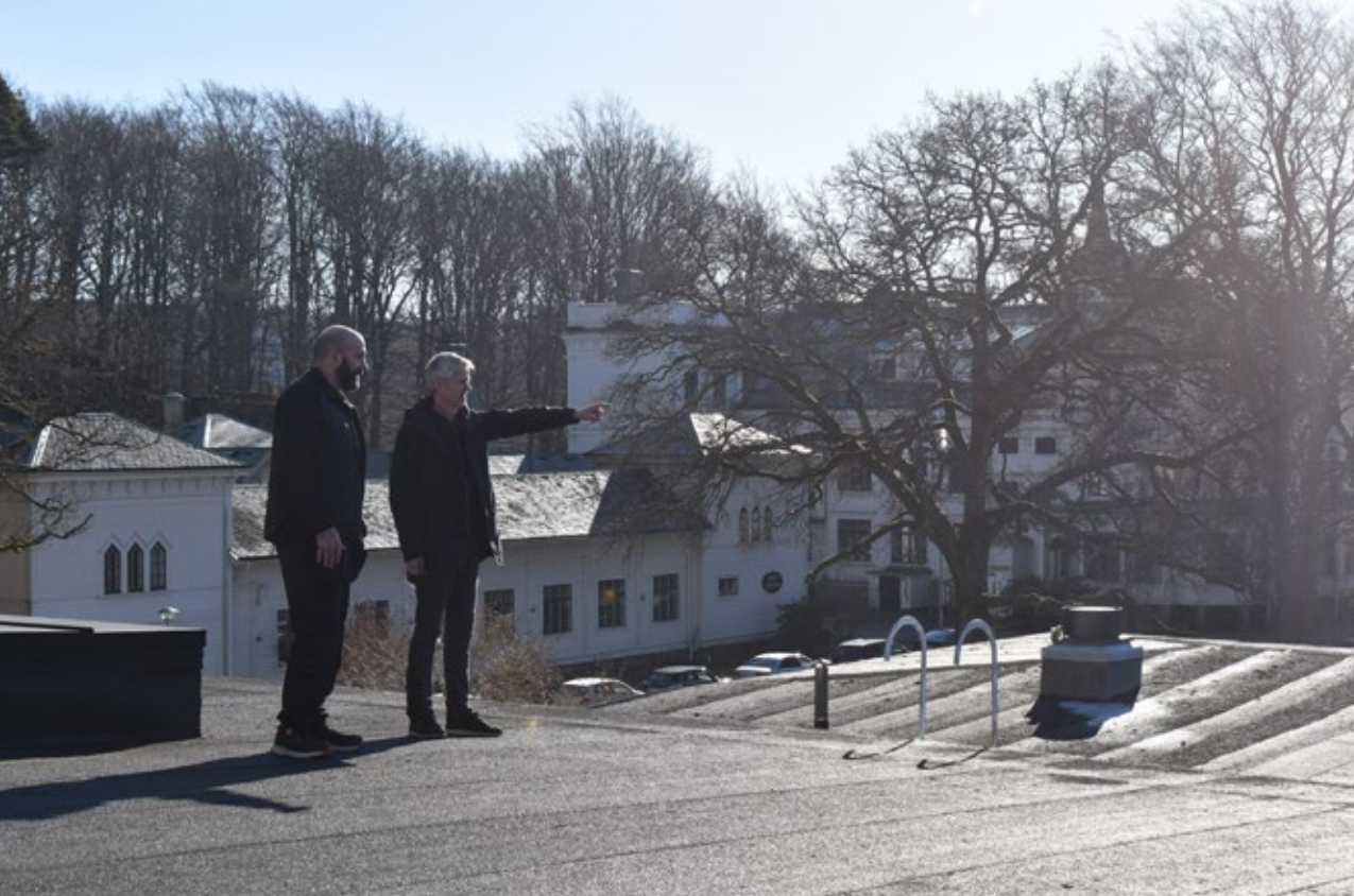
Rektor Sören Eriksson och övervakningsmästare Patrick McAvey inspekterar Mellangårdens olika tak och planerar för placering av omkring 400 solpaneler.
